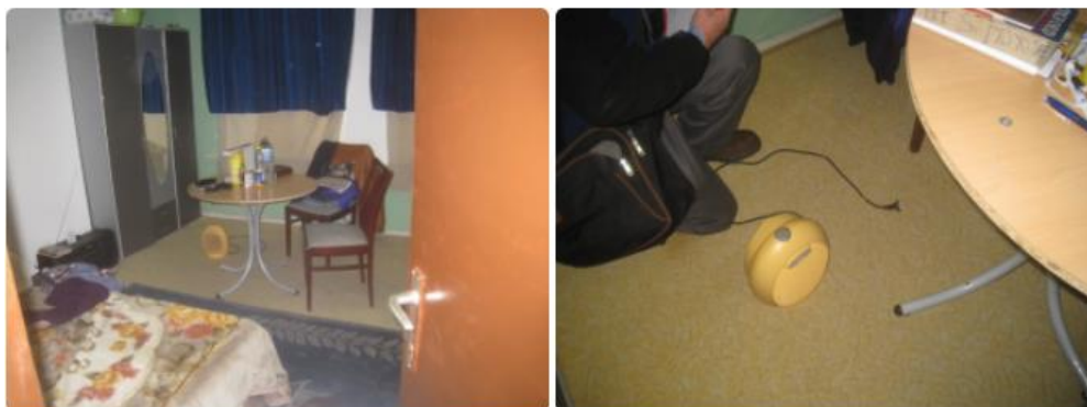
Deze kamer wordt verwarmd met een mobiele elektrische radiator, wat geen vast verwarmingsapparaat is, en bovendien niet op een apart circuit is aangesloten.
